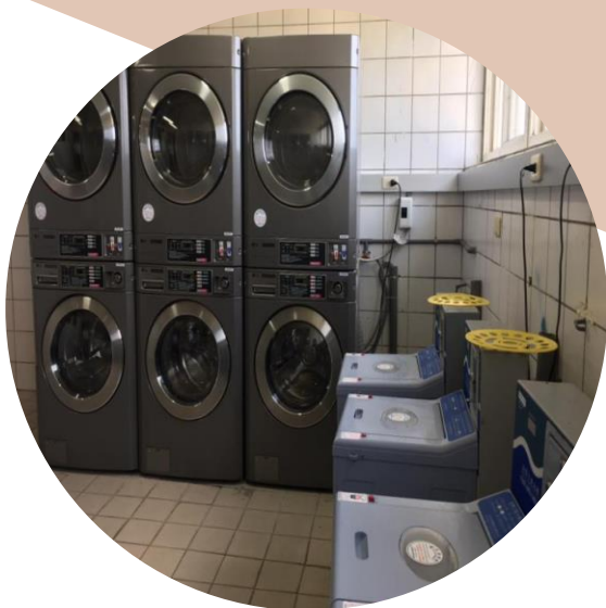
頂樓洗烘衣機間
