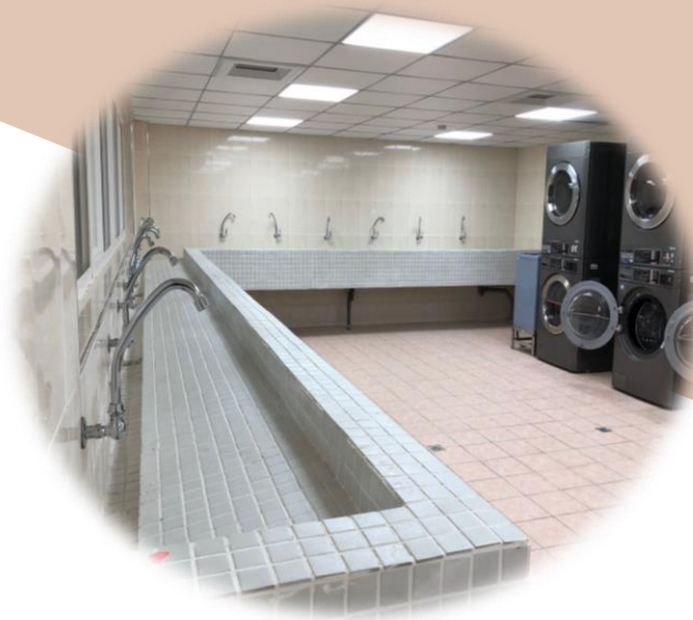
洗烘衣機房 (各樓層皆有)
